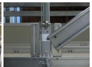
写真2 ブレース下部状況
