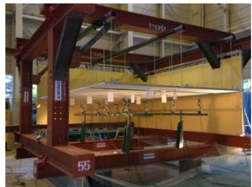
図2 試験体設置状況
