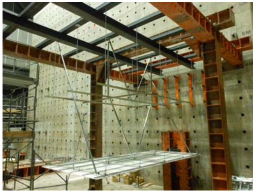
写真1 試験体設置状況 (2段ブレース)
