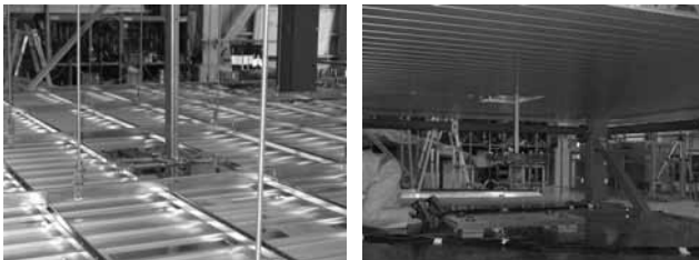
写真 2 吊り下げ(支柱)詳細
