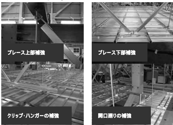
写真2 各補強の詳細
